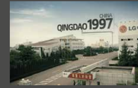
China : Chiller (Qingdao)
